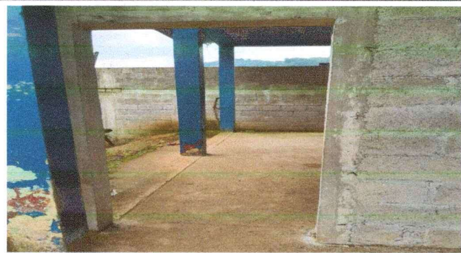
Foto 3: Rehabilitación de puertas y cernido de pared.
